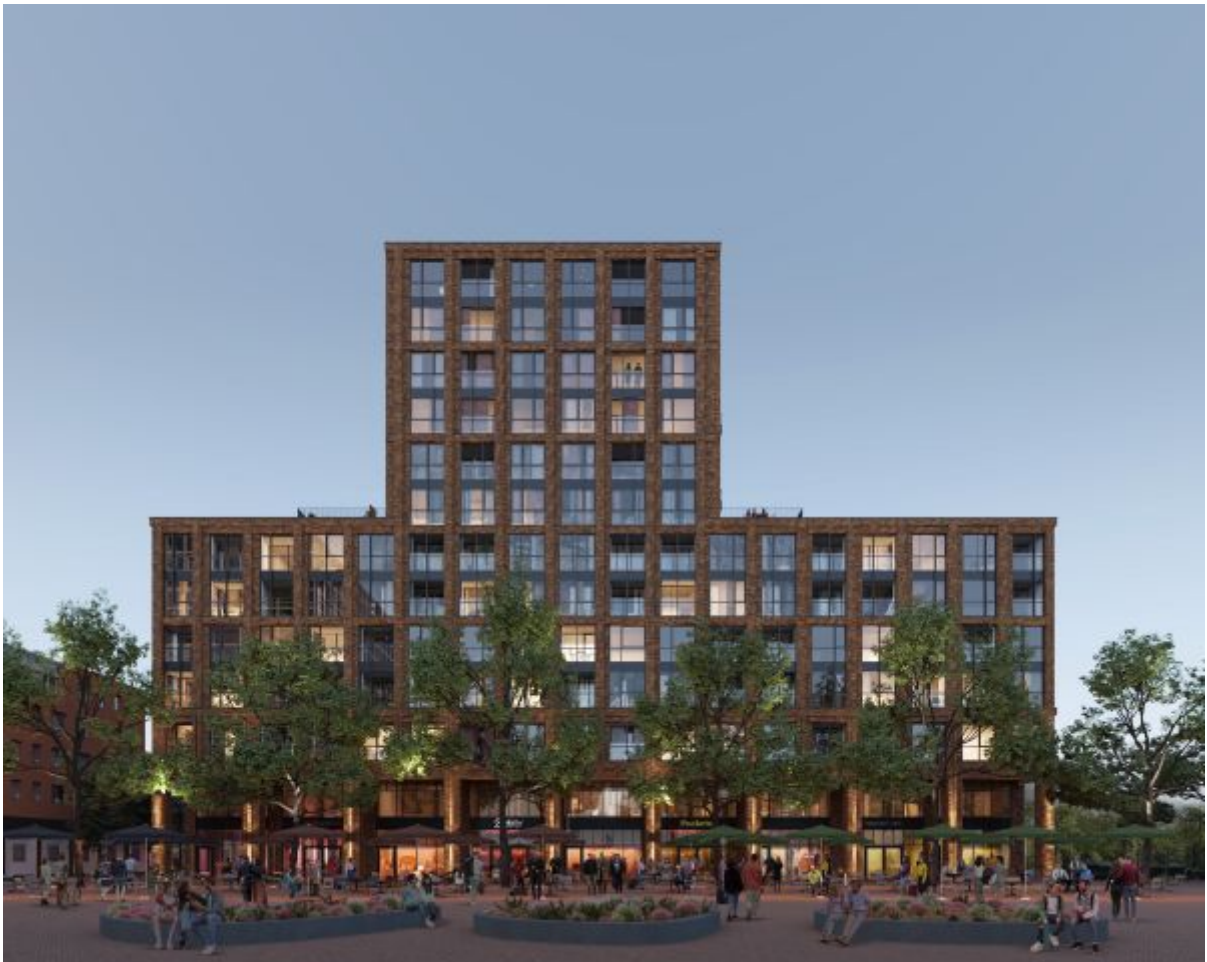
gebouw Sem: aanzicht Raadhuisplein
